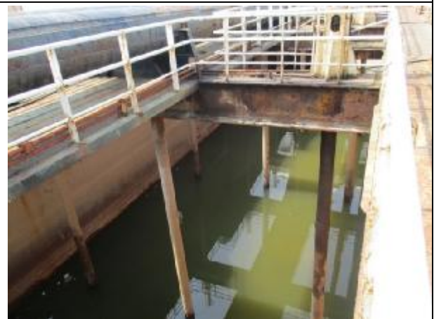
1.12 泥舱内结构锈蚀
