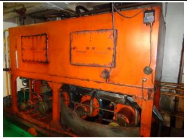
2.22 滑油储存设备
