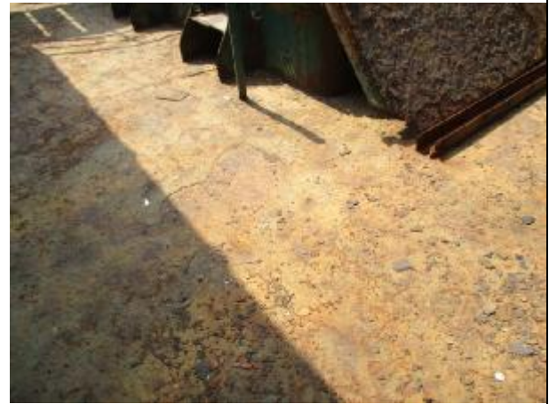
1.8 艙部主甲板锈蚀严重
