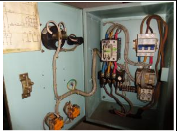
3.16 主机海水泵电控箱
