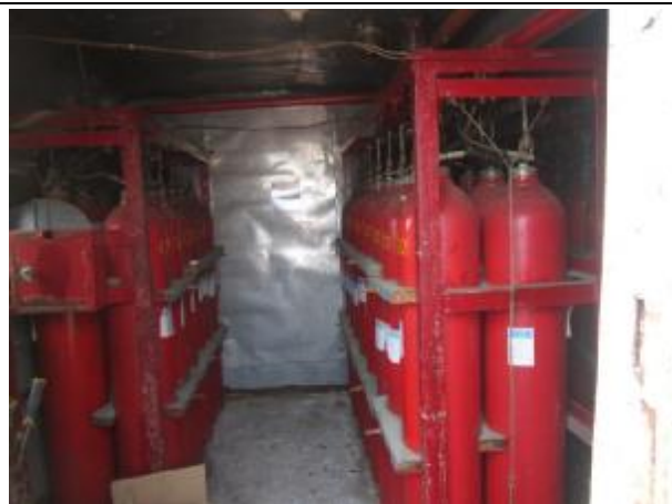
2.17 固定 CO2 灭火系统
