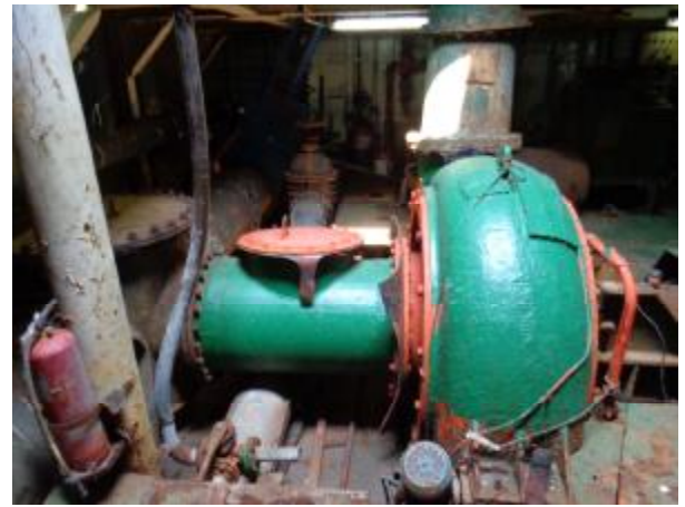
2.20 左侧泥泵及管道设备
