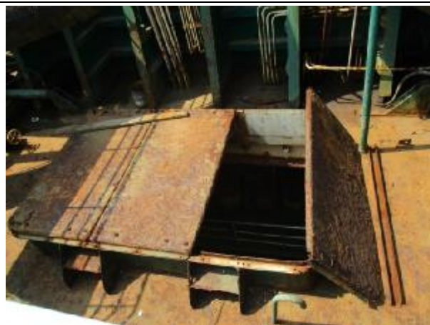
1.11 艙部舱口盖损坏
