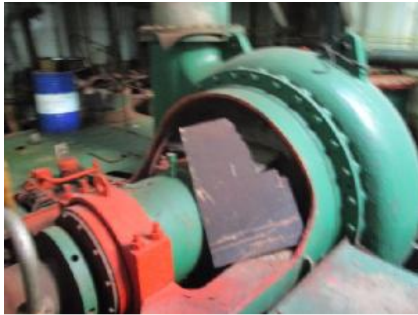
2.19 右舷泥泵设备
