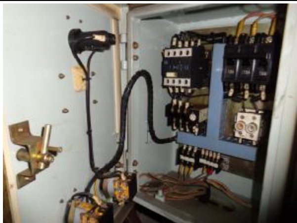
3.17 主机润滑泵电控箱
