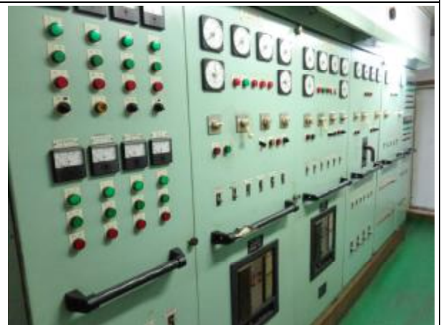
3.12 6屏的主配电控箱
