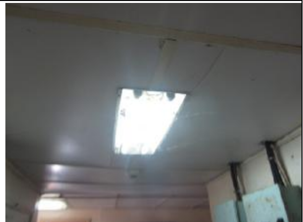
3.18 外壳损坏的灯具
