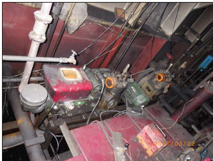
98. 柴油机驱动的主空压机。 机。
