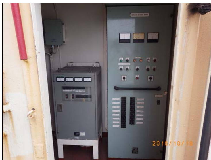
162. 应急电瓶充电机和 充放电板
