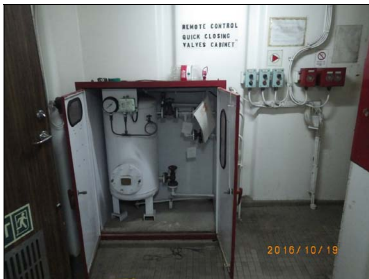
155. 机舱速闭阀控制箱 和风油切断按钮
