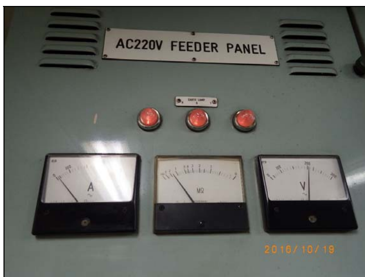
138. 主配电板 220V 绝缘指示正常
