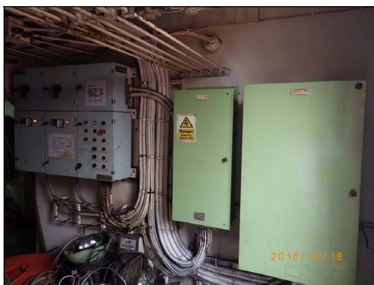
27. 艏楼索具间内锚机和舱盖液压装置的电气箱
