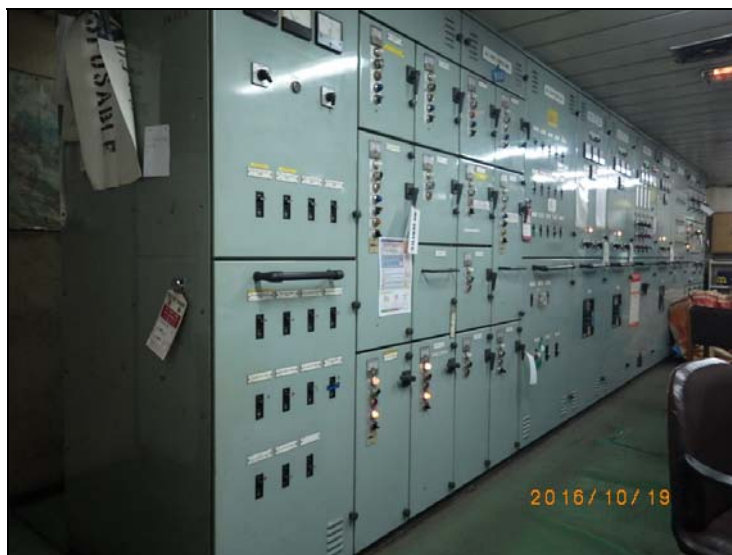
137. 机舱上平台层,主配电板
