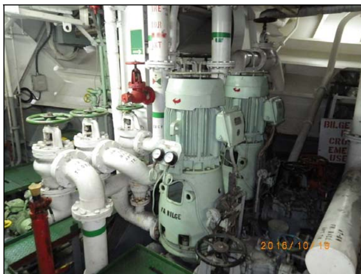
126. 机舱底层, 消防/通 用泵
